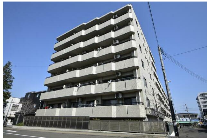
只今、リノベーション工事中。2025年6月4日に完工予定。
