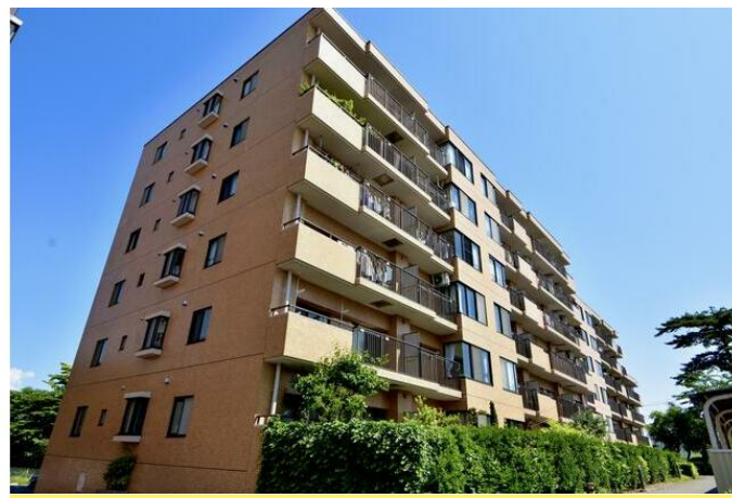
只今、リノベーション工事中。2025年7月19日に完工予定。
