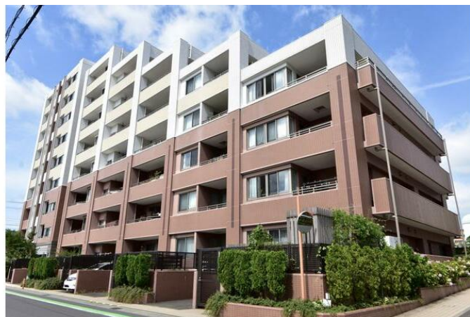
高級感があるタイル張りの外観♪
