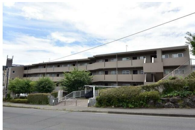
只今、室内のリノベーション工事中。2025年9月25日に完工予定。
