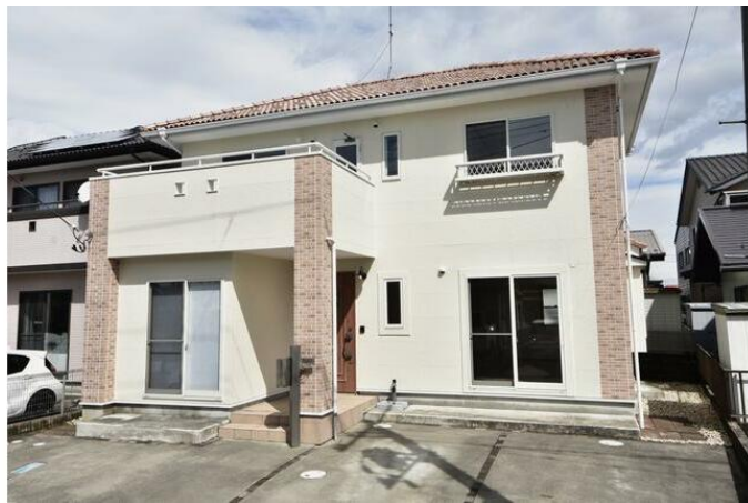
洋瓦屋根のお洒落な外観♪ 駐車スペース3台♪（並列2台+側面1台）
