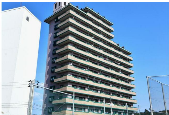
※現在、大規模修繕工事で建物全体に足場とネットが掛かっています。(写真は大規模修繕工事の前)
