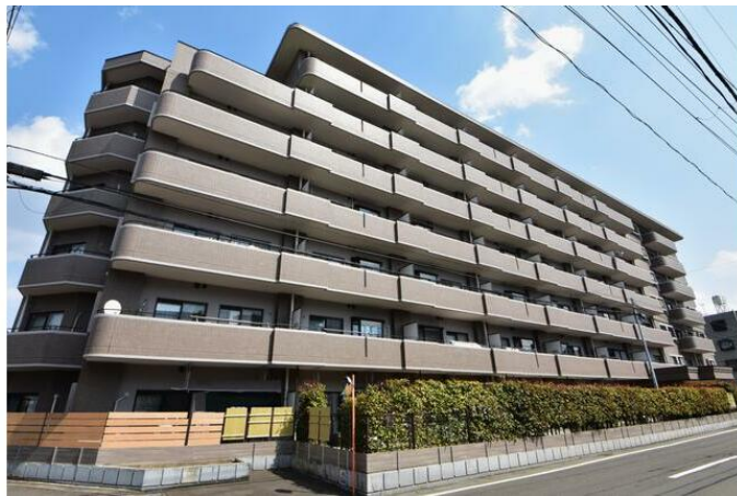
只今、室内をリノベーション工事中。2026年6月17日に完工予定。
